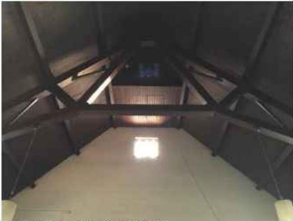
Photo 1 - Platelage, pannes de bois et structure d'acier
