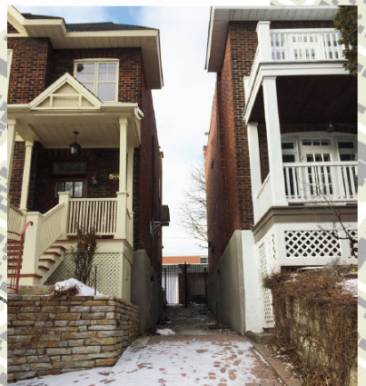
Sous-sol 1 - Accès de plain-pied au sous-sol
