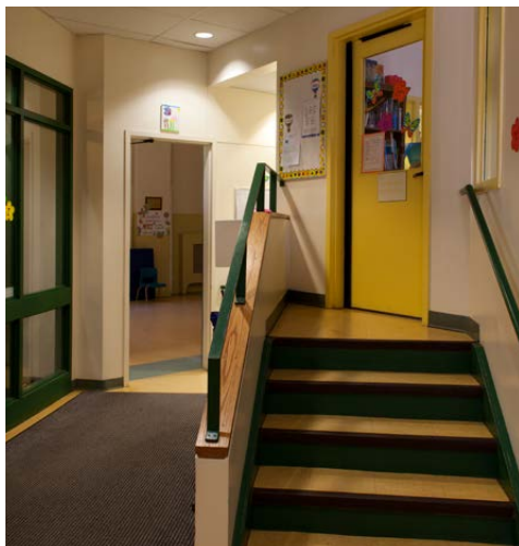
AU REZ-DE-CHAUSSÉE, LES ARCHITECTES DOIVENT COMPOSER AVEC DEUX NIVEAUX DE PLANCHER, EXPLIQUANT POURQUOI LES AIRES DE CIRCULATION DU CPE COMPORTENT DES PALIERS.
