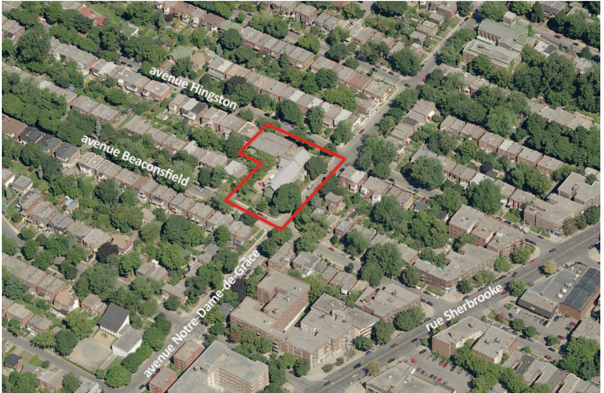
Photo aérienne du site (Source : Bing, 2012)
